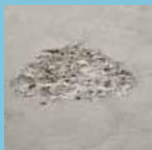
Rengør beskadigede områder grundigt
