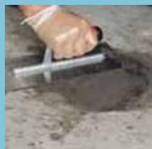
Rengør beskadigede områder grundigt
